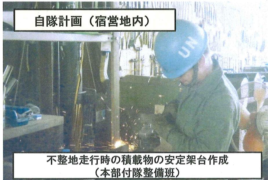
不整地走行時の積載物の安定架台作成
